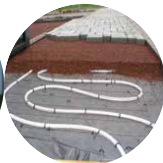
Parkirne površine za stranke podjetja Pietsch Haustechnik GmbH. Izolacija parkirnih površin z izdelkom URSA XPS N-VII-L
