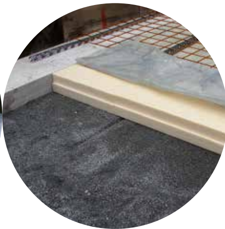
URSA XPS N-III-L debeline 160 mm pod kletne tlake s pasovnimi temelji
