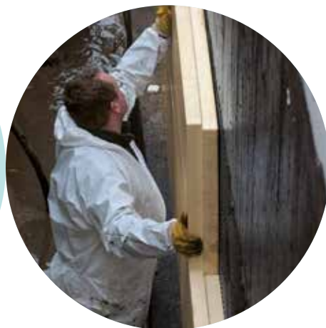
Obdelava izolacijskih plošč URSA XPS na zunanjem zidu kleti
