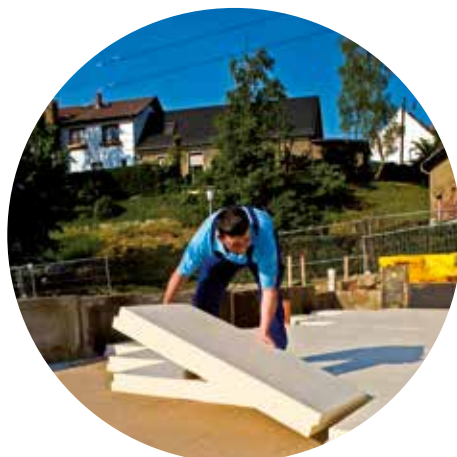
Polaganje izolacije iz ekstrudiranega polistirena URSA XPS na tamponski sloj
