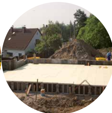
Stično položena izolacija iz ekstrudiranega polistirena URSA XPS za enodružinsko hišo
