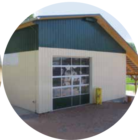
Komercialna gradnja na talni plošči s pasovnimi temelji
