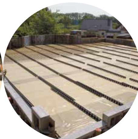
Položena izolacija iz ekstrudiranega polistirena URSA XPS z vmesno plastjo in distančniki za armaturno mrežo
