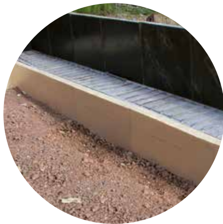
URSA XPS N-III-L debeline 160 mm pod kletne tlake s pasovnimi temelji
